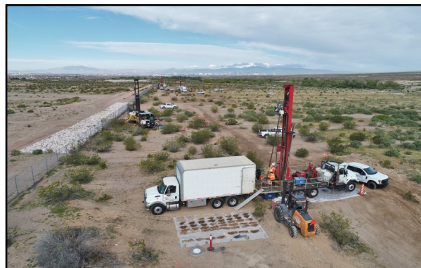
Instalación de pozos de monitoreo cerca del Canal Las Vegas, abril 2020
