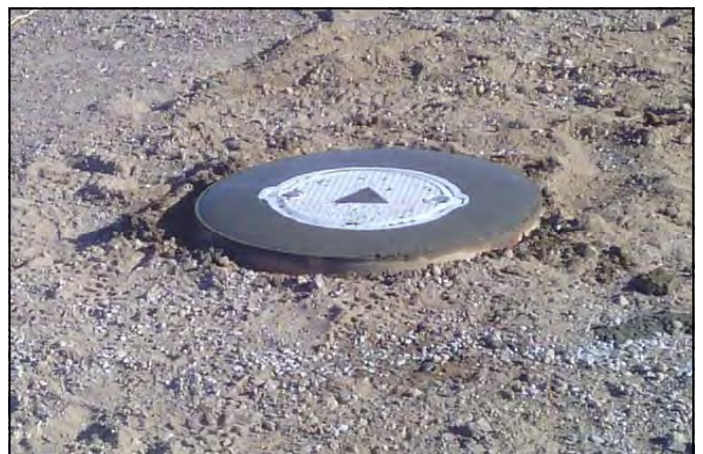
Una boca de pozo monitoreo típico
