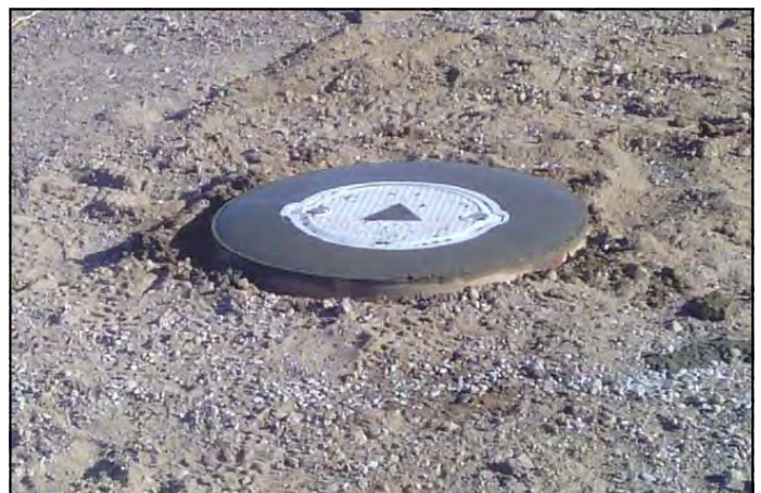
Una boca de pozo monitoreo típico
