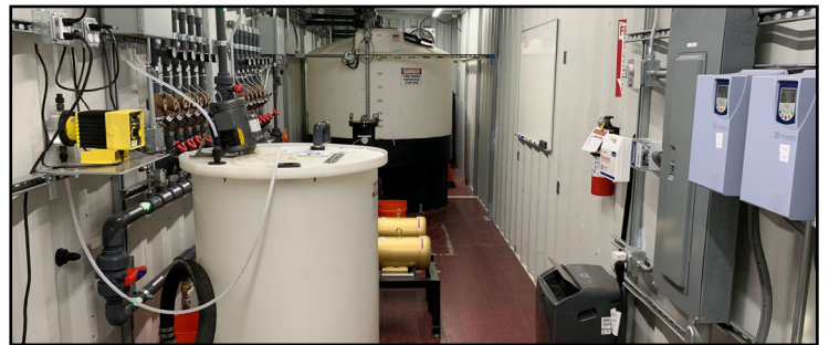
Equipo del Sistema de Inyección y Extracción para un estudio de Tratabilidad del NERT
