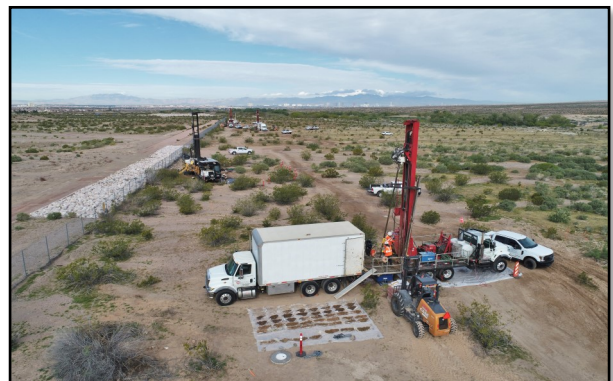
Instalación de pozos de monitoreo cerca del Canal Las Vegas, abril 2020
